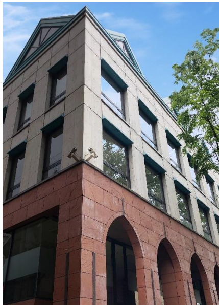
【新オフィスの外観】
