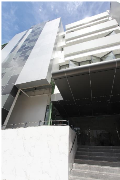
【新オフィスの外観】
